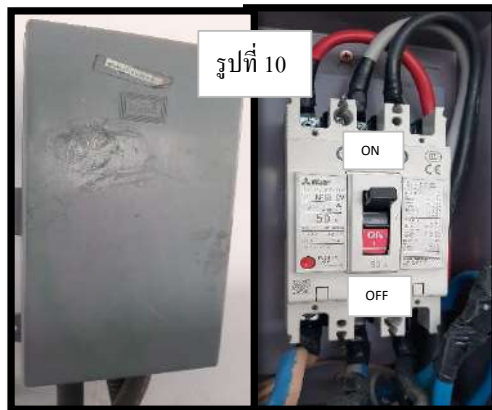
รูปที่ 10 MAIN BREAKER AIR COMPRESSOR
